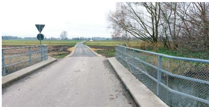
Die erneuerte Gemeindeverbindungsstraße zwischen der Rößbrücke und Niederwöhr
